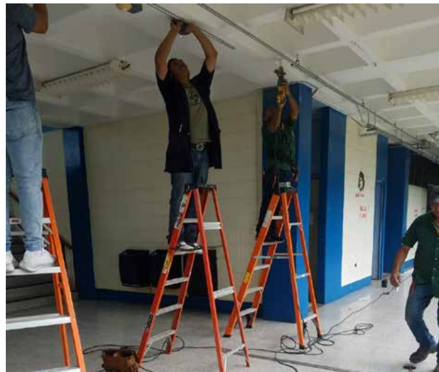
Servicios Generales | Cambio de candelas fluorescentes en el auditorio Ramón Oqueli en la planta baja del Edificio A1.
