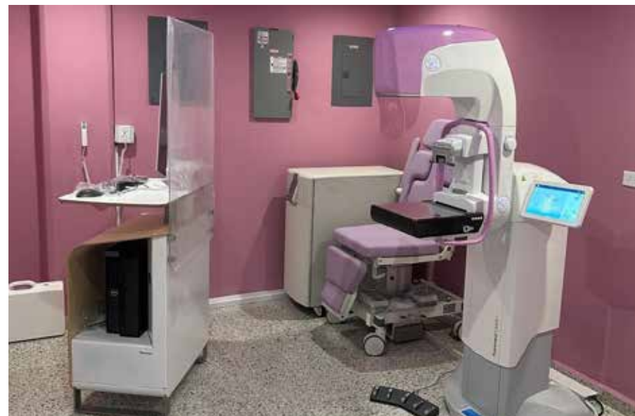
FCM-CIBIDIR | Se realizaron mejoras de infraestructura en el área de imágenes biomédicas del centro.
